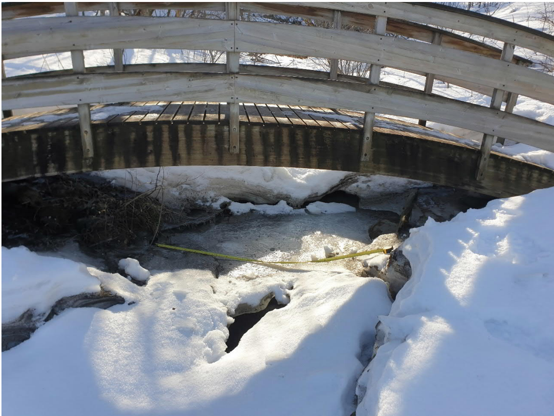
Figur 5, viser et bilde av bekken der denne var snøfri.
