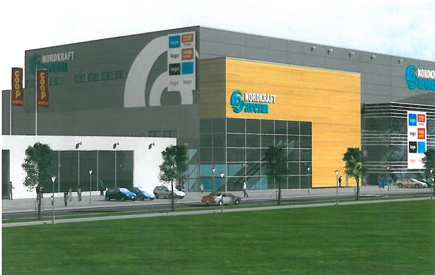
Ishall/flerbrukshall i Narvik – NORDKRAFT ARENA
